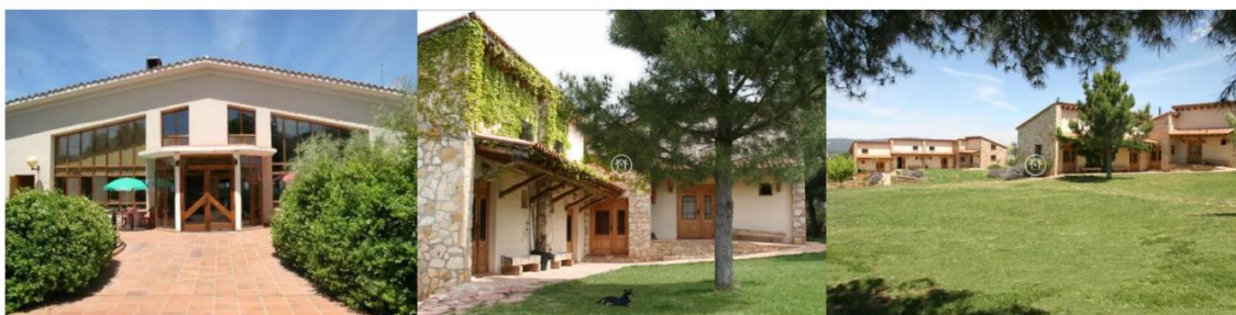
Imagen 24. Instalaciones Campamentos Ecoalf
